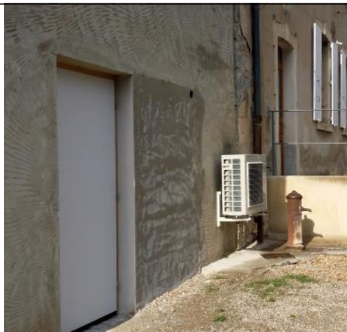
L'entrée du nouveau WC public dans la cour, accessible pour handicapés comme exigé par la loi.
