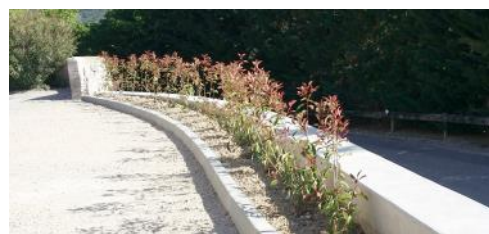
Le mur entre l'entrée de la cour et la D570.
