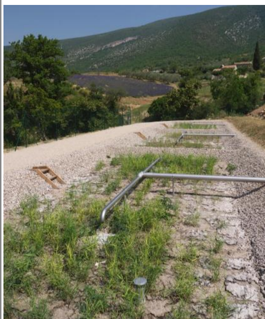
Dans ce bassin, les roseaux et autres organismes bio dégradent la pollution dissoute.
